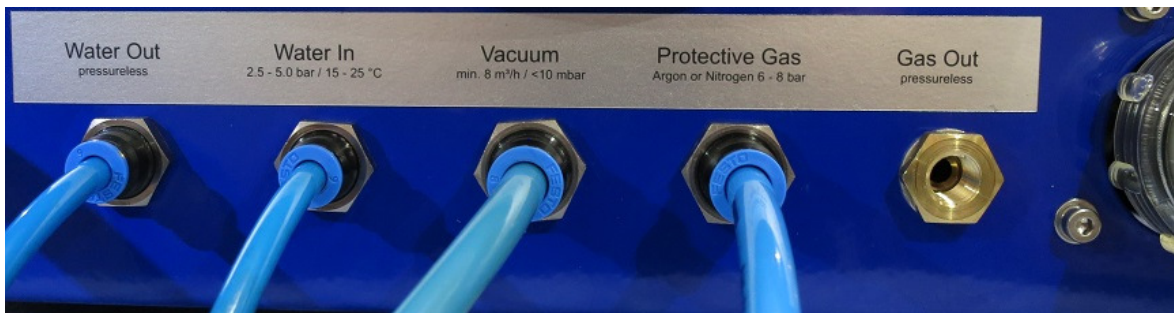
Abb. 12: Kontrolle der rückseitigen Anschlüsse
